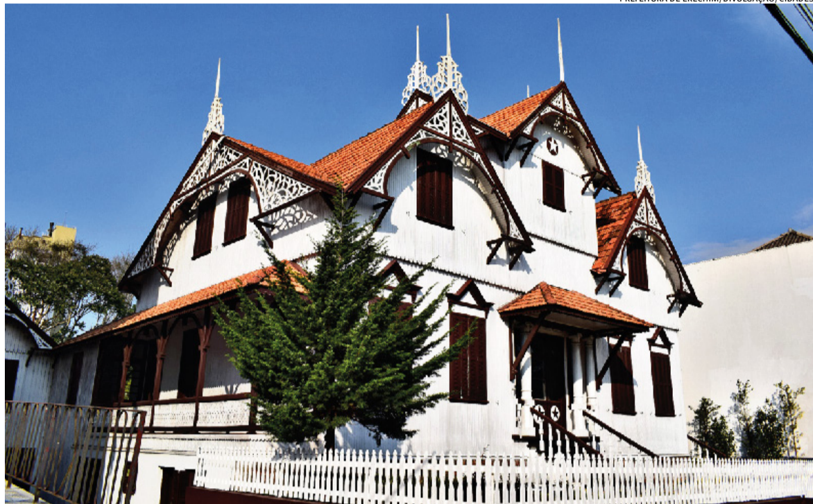
Prédio de madeira, construído na década de 1910, foi tombado pelo Iphae em 1982 e deve receber R$ 6,6 milhões em obras
