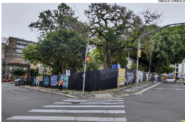
Praça Dom Feliciano está sendo reformada desde novembro de 2025
