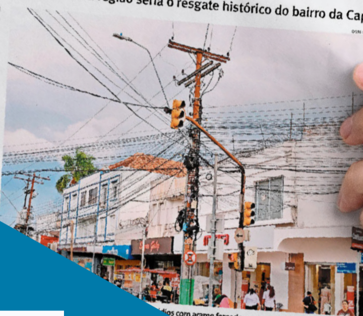
Edifícios com arame farpado e estruturas de proteção instaladas
