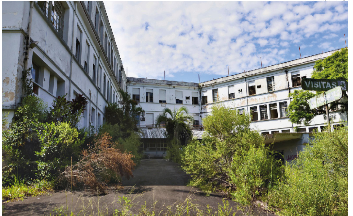
Adquirida em 2023 pela Vila Nova, unidade de saúde necessitaria de R$ 80 milhões para ser reativada
