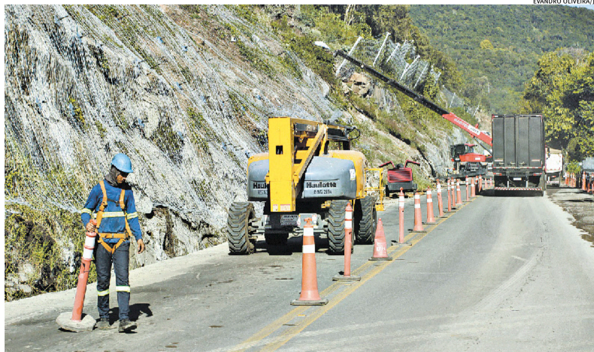
Sistema "pare e siga" é mantido ao longo do trecho de obras da rodovia BR-470, na Serra Gaúcha
