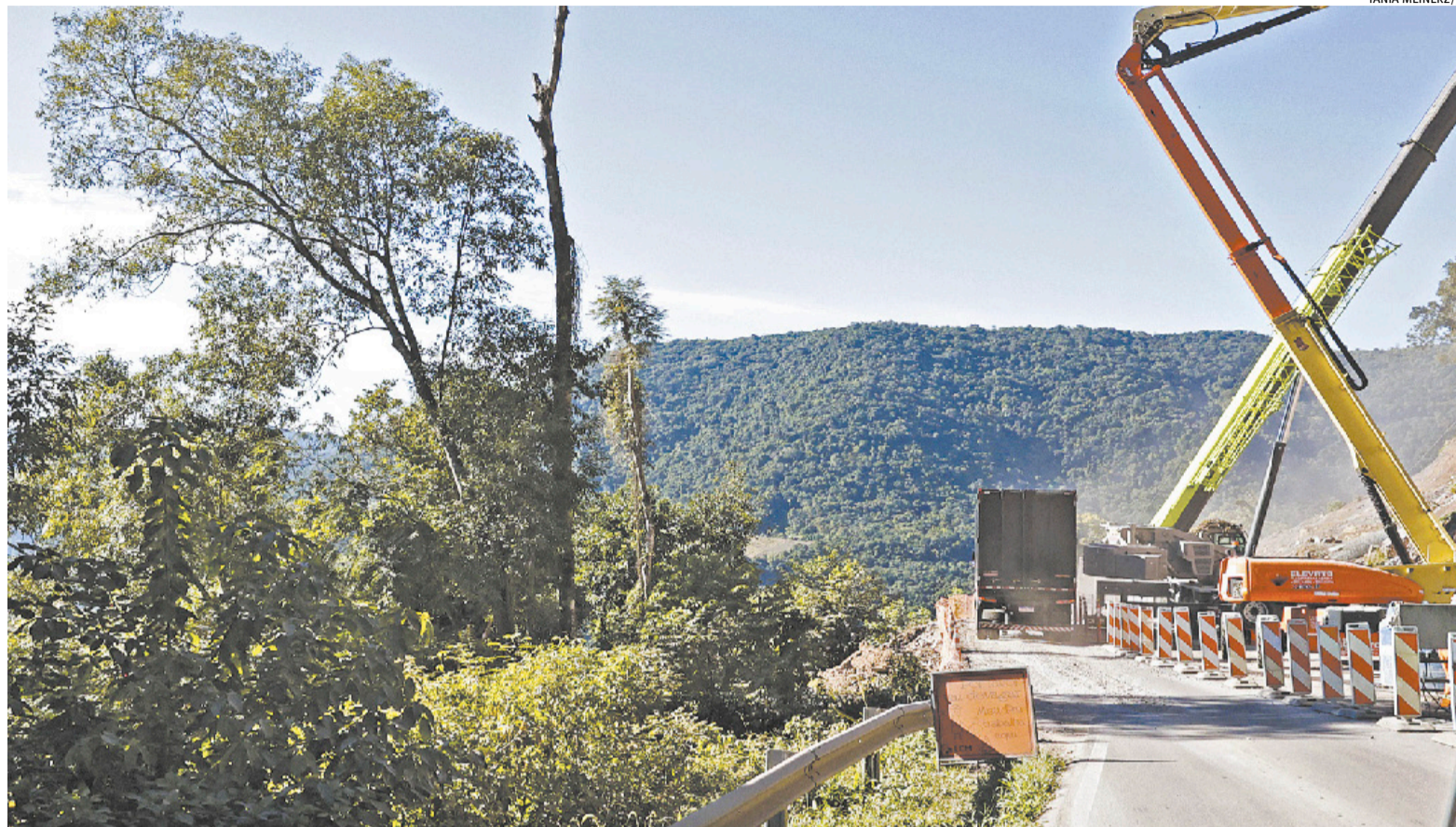
Restauração de trecho de 25 quilômetros da rodovia deve seguir até o final de 2026, com liberação gradual de pontos na estrada
