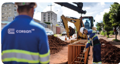
OBRA DE REDE DE ESGOTO
