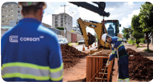
OBRA DE REDE DE ESGOTO
