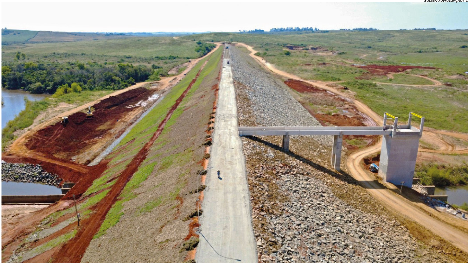
Estrutura em São Gabriel ainda passará por testes; com aporte de R$ 365,7 milhões, complexo pode armazenar 148 milhões de metros cúbicos de água p. 11
