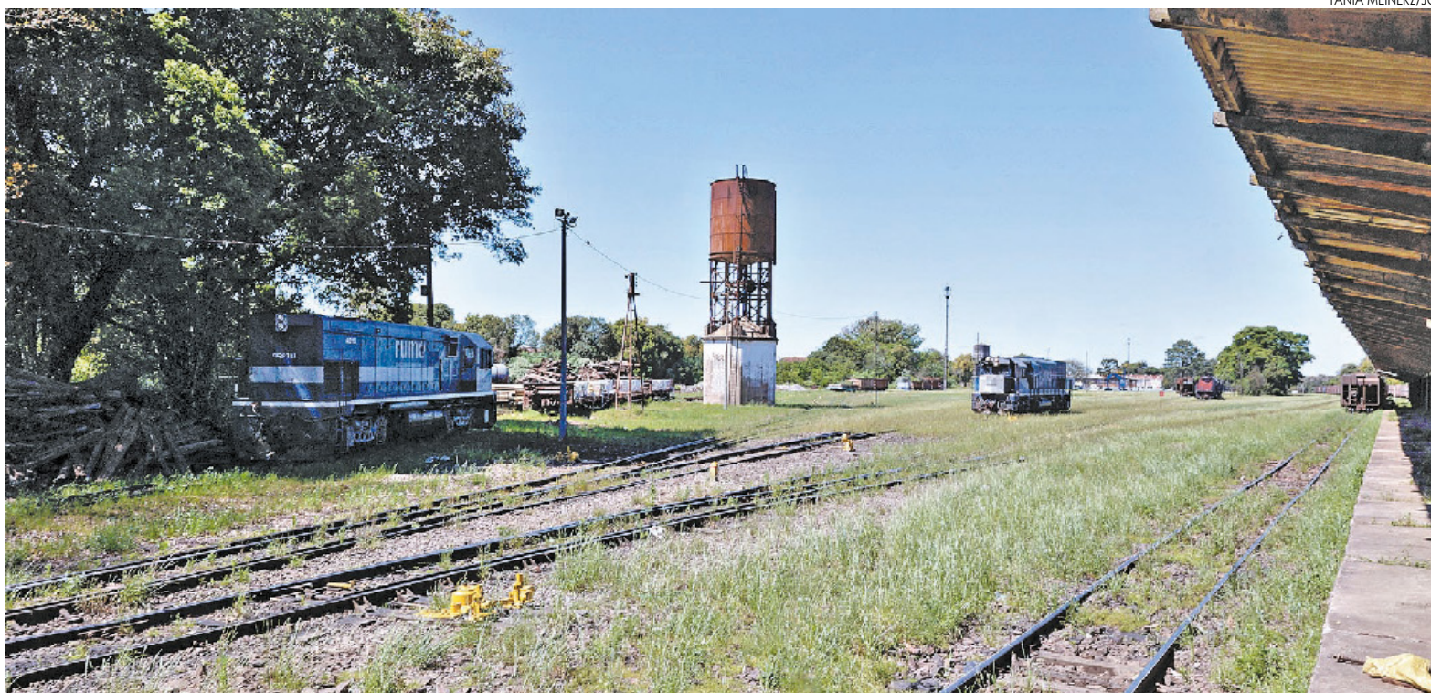
Primeiro bloco vai cuidar da infraestrutura ferroviária em si, caso dos trilhos, dormentes, pátios e sistemas de operação da malha
