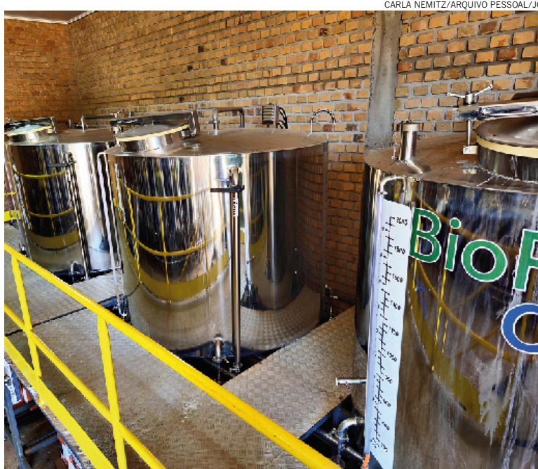
Construção da biofábrica auxilia na produção dos próprios insumos
