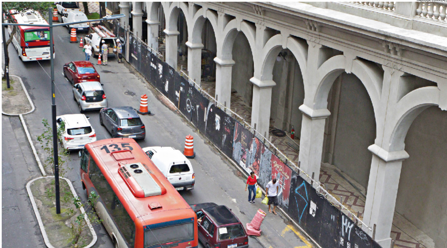
Em obras de revitalização desde 2022, estrutura ao longo da avenida Borges de Medeiros voltará a ser liberada para circulação até domingo p. 19
