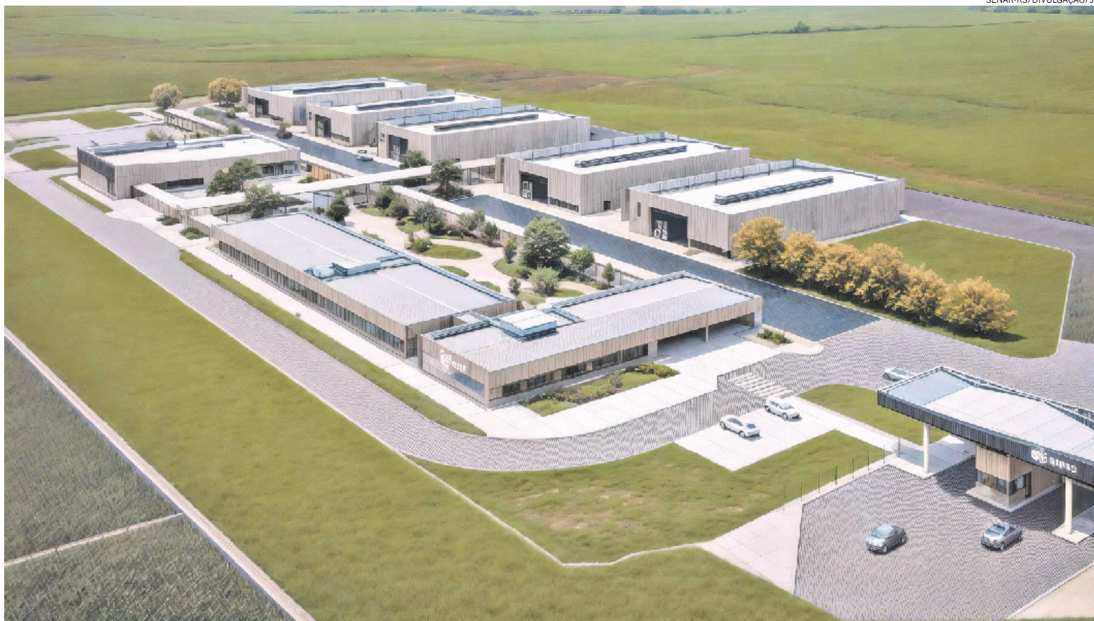
Centro de Formação Rural em Hulha Negra, conduzido pelo Senar-RS, é dedicado exclusivamente ao treinamento técnico no campo
