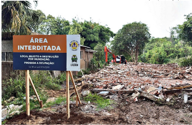
Foram mapeadas sete áreas de arrasto que terão as residências inutilizadas
