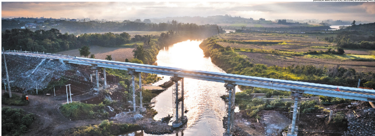
Nova ponte da ERS-130 sobre o Rio Forqueta, que liga Lajeado e Arroio do Meio, é cinco metros mais alta que a antiga, exemplo de adaptação à condição climática
