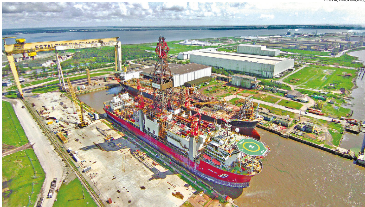
Estaleiro Rio Grande terá, no pico da construção dos navios da Transpetro, 1.500 trabalhadores
