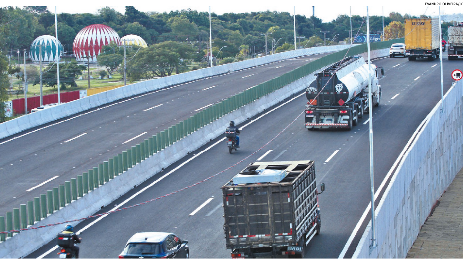
Obras viárias na rodovia BR-116 estarão abertas ao tráfego ainda nesta semana, diz o Dnit; investimento do governo foi de R$ 130 milhões p. 20
