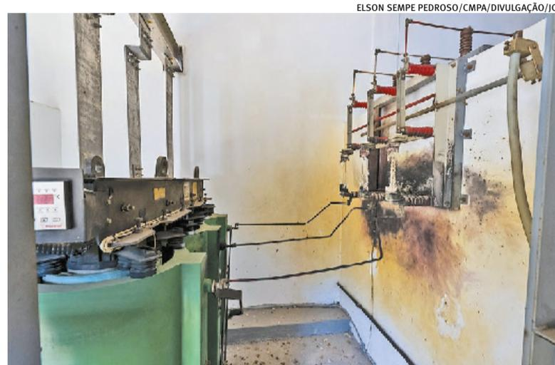
Sobrecarga elétrica no transformador causou danos à rede interna
