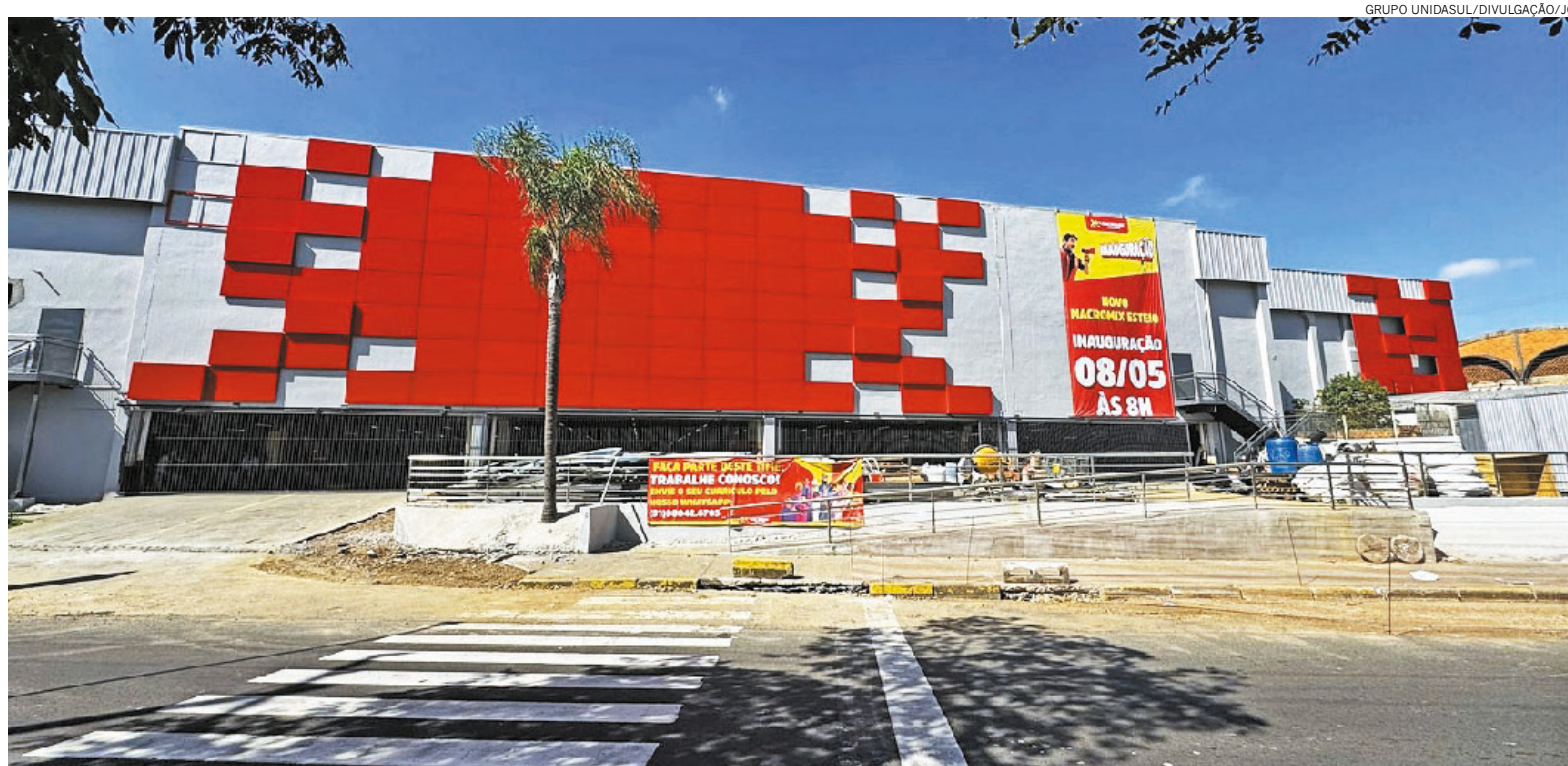
Unidade foi completamente reformada e vem com nova fachada da bandeira do grupo Unidasul, terceiro maior supermercadista do Rio Grande do Sul
