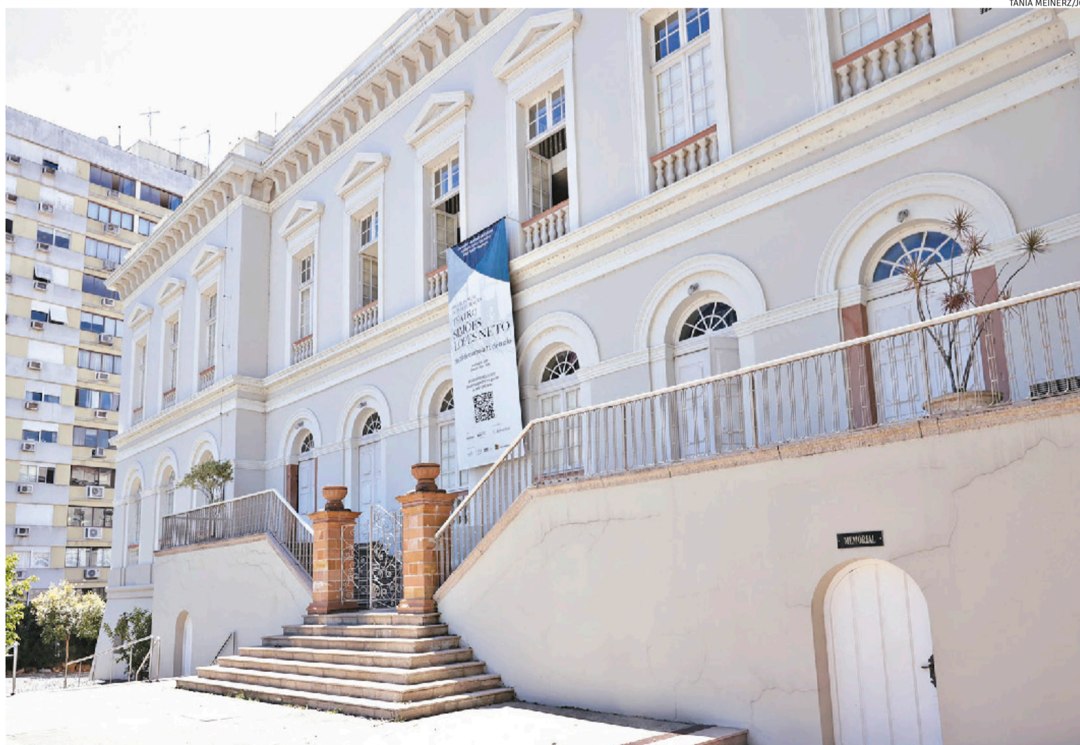
Histórico espaço da cultura gaúcha ficará fechado para obras de prevenção contra incêndio e acessibilidade; expectativa de reabertura é para junho de 2026
