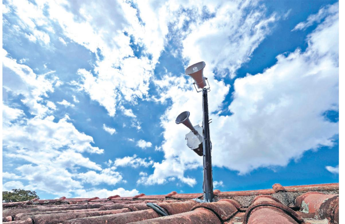
Colocada no telhado de uma escola, na região central, equipamento consegue atingir um raio de 1,5km
