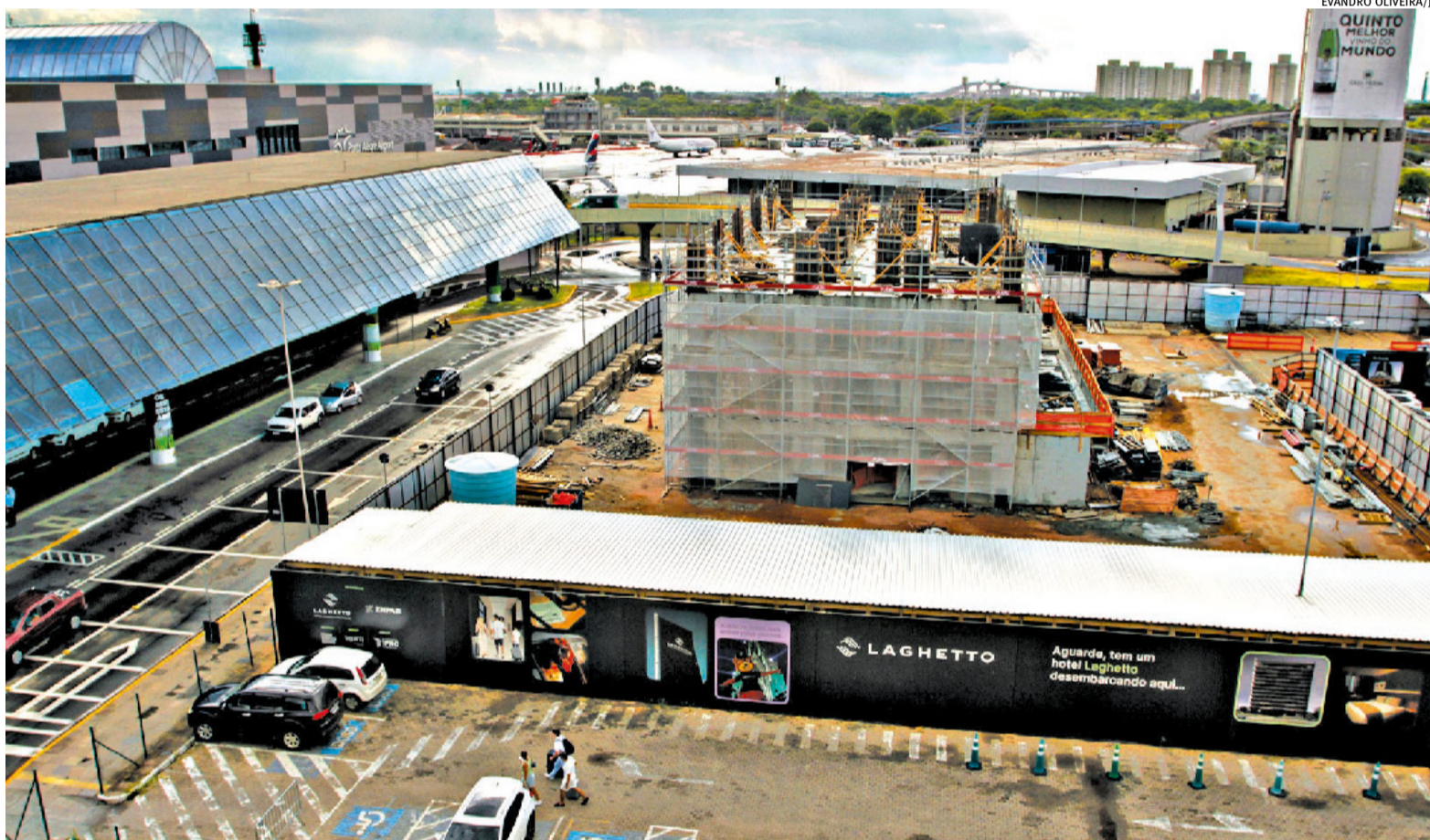
Com previsão de inauguração para agosto de 2026, empreendimento da rede Laghetto tem aporte de R$ 58 milhões e está em ritmo acelerado de construção p. 8
