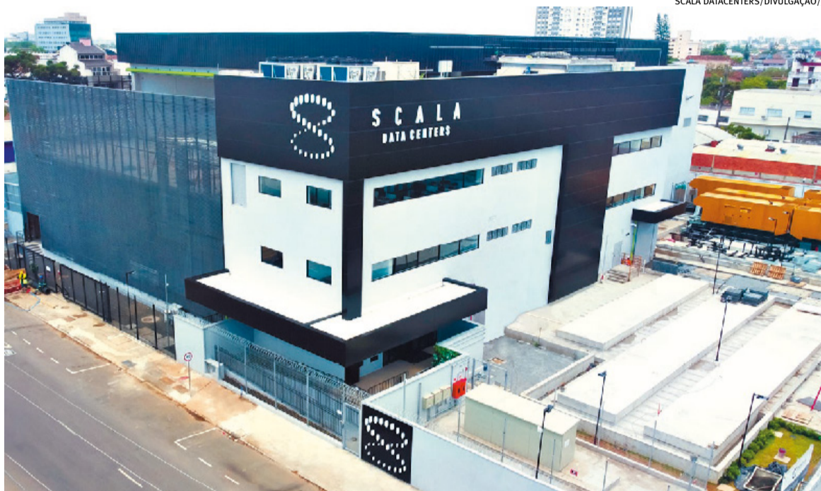
Empresa tem operação na avenida Pernambuco, na Zona Norte de Porto Alegre, e prepara nova iniciativa
