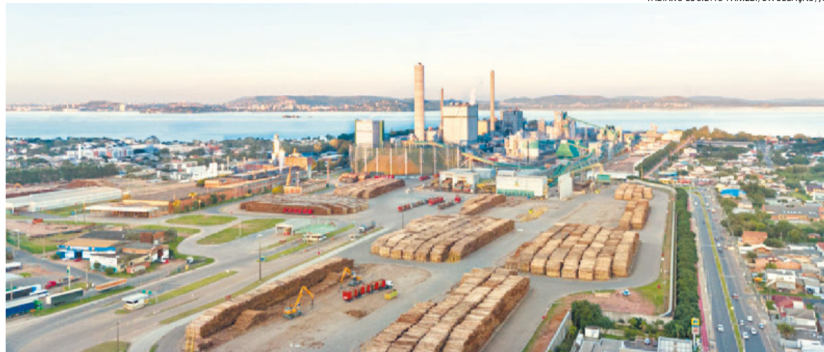
CMPC concluiu projeto de melhorias ambientais em fábrica de Guaíba, que teve expansão da produção
