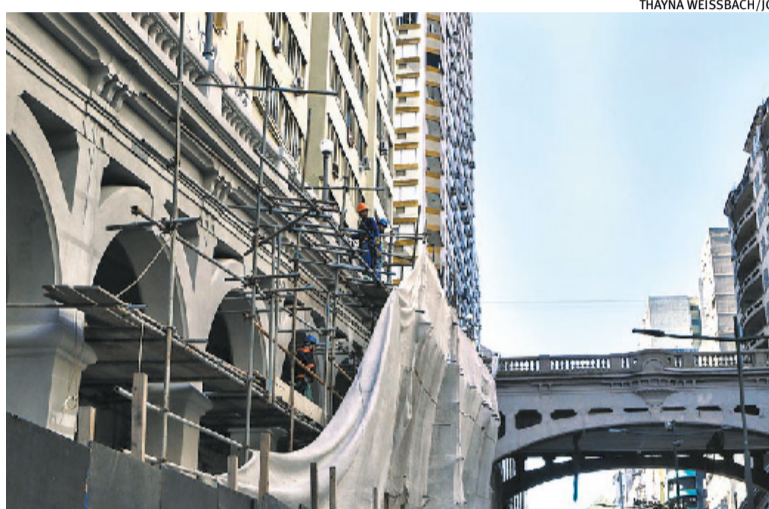
Orçamento em R$ 13,7 milhões, valor da reforma já supera R$ 16 milhões
