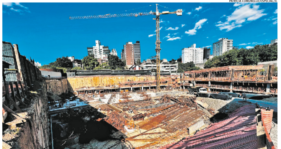
Obras do empreendimento com Zaffari avançam em frente à Encol, com entrega prevista para 2027
