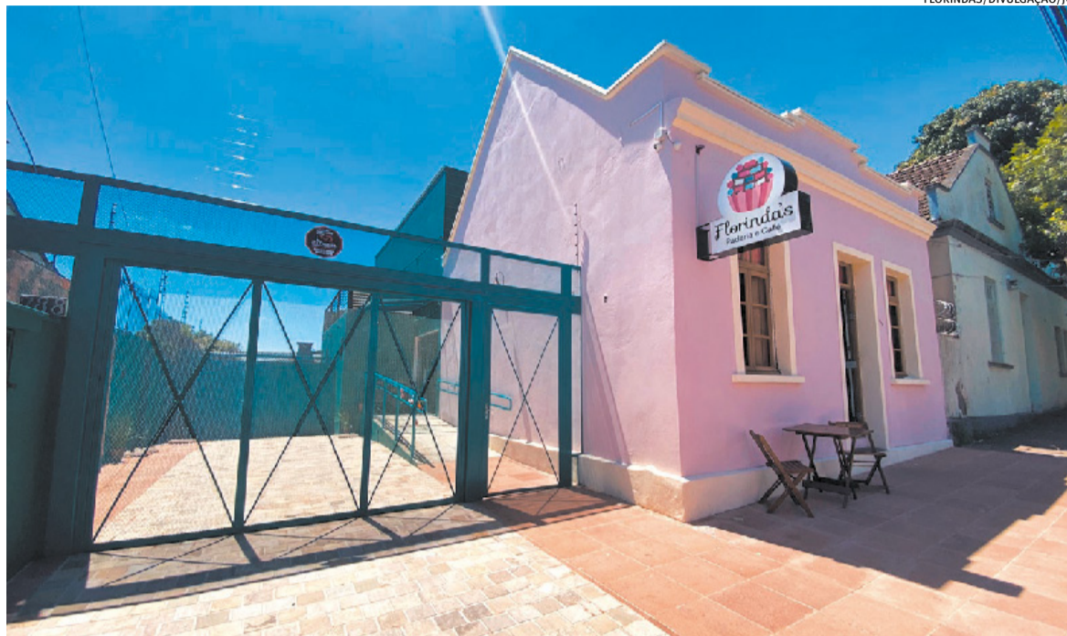
Imóvel do estabelecimento, em Novo Hamburgo, estava descaracterizado devido a alterações anteriores
