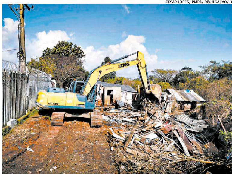
Obras no dique do Sarandi também já estão em curso na Capital
