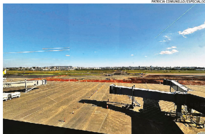
Obras em áreas de taxiamento devem terminar em dezembro
