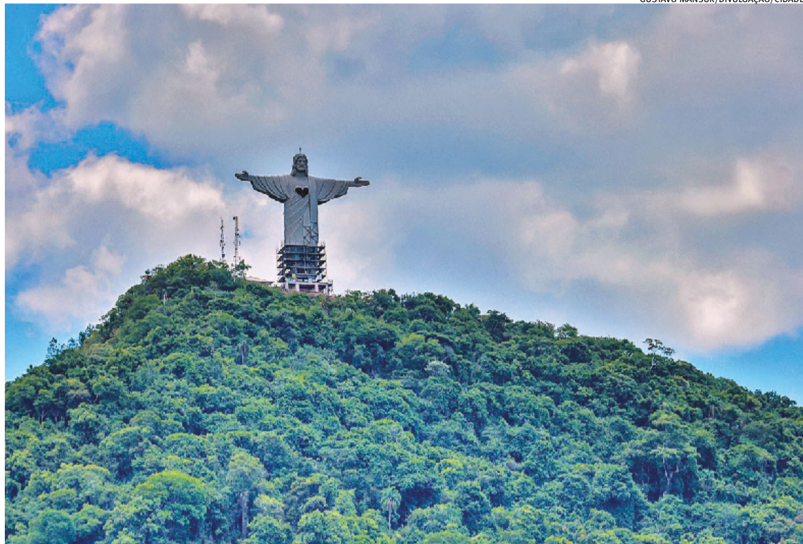
Obras no complexo do Cristo Protetor de Encantado estão previstas para terminar em dezembro
