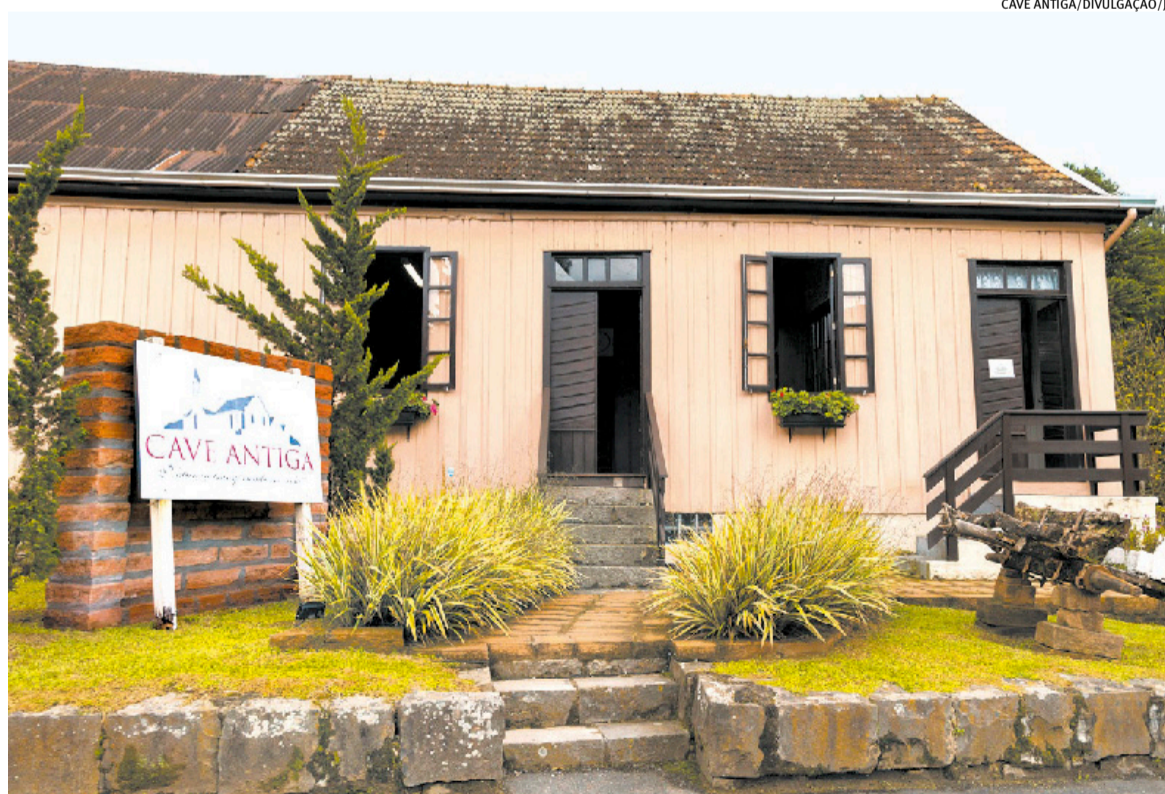
Estrutura histórica foi concluída em 1948, no município da Serra, pela família Gasperin
