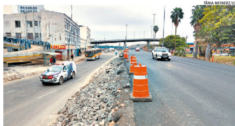
Alça permitirá acesso ao Túnel da Conceição através da avenida Farrapos
