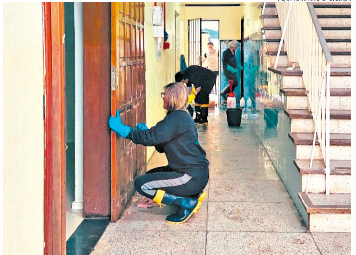
Serviços de reparos ocorrem em diversos locais, como no Centro de Educação São Vicente de Paulo, na Capital
