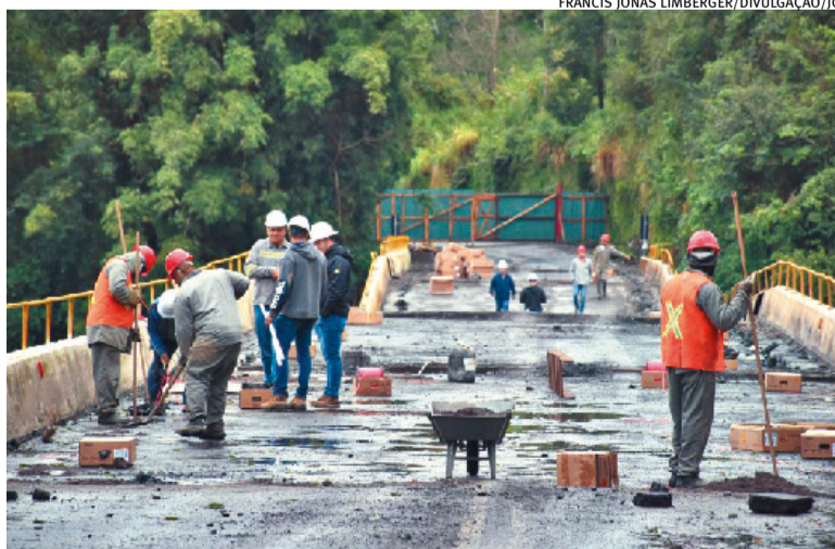
Equipe trabalha para a liberação da Ponte sobre o Rio Caí, em Vale Real
