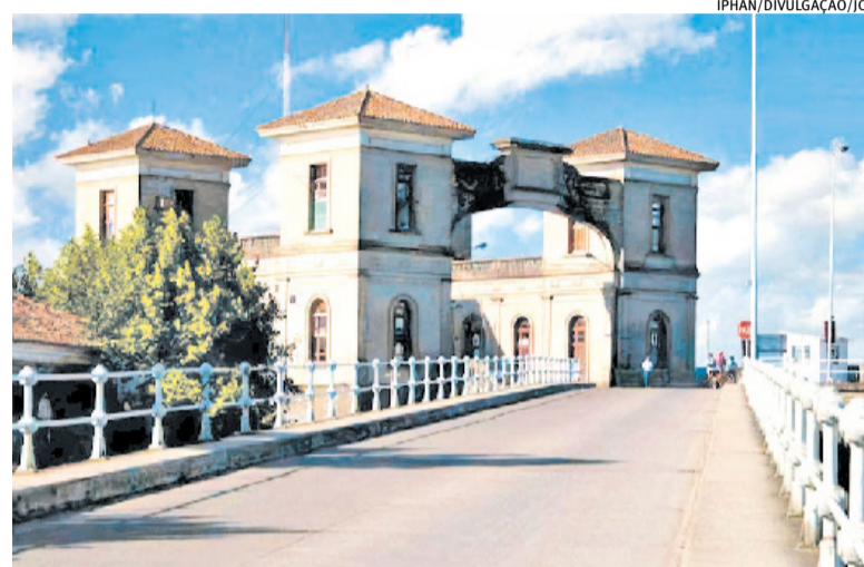
Ponte Barão de Mauá não dá mais conta do fluxo de cargas e veículos
