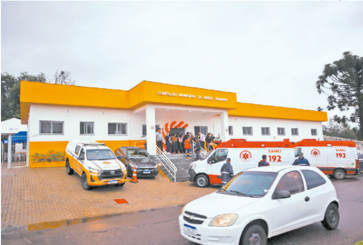
Localizado na faixa da ERS-020, local pretender centralizar atendimentos para a população da cidade
