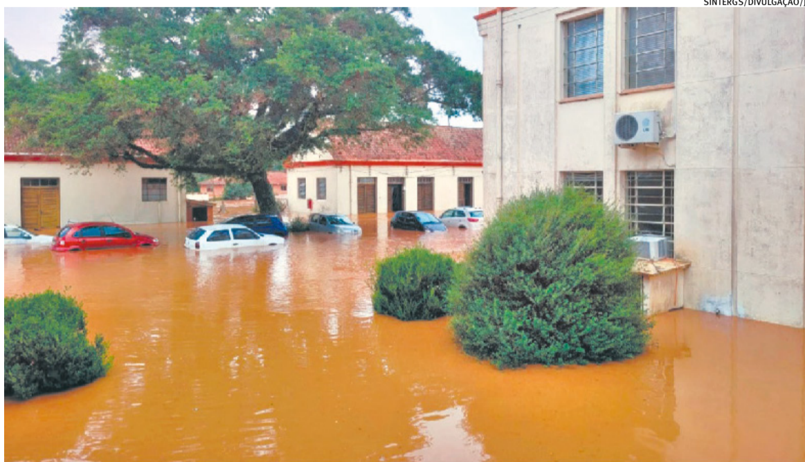
Localizado em Eldorado do Sul, prédio teve dois andares inundados e está em situação de calamidade
