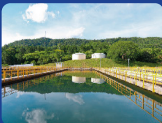
NAS UNIDADES DE TRATAMENTO, A ÁGUA É PURIFICADA
