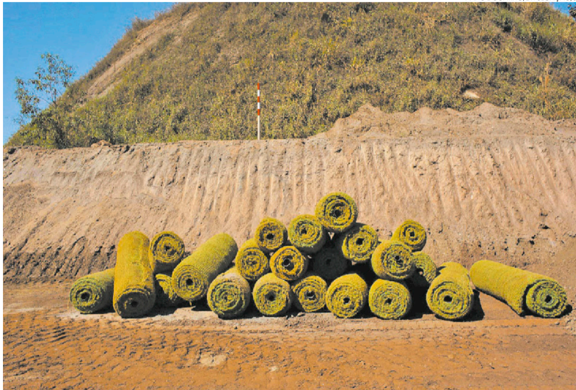
Feita a partir de fibra de coco, manta é colocada sobre a estrada e suporta cerca de 300 toneladas
