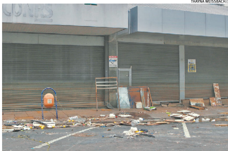
Enchentes causaram prejuízos severos a estabelecimentos gaúchos
