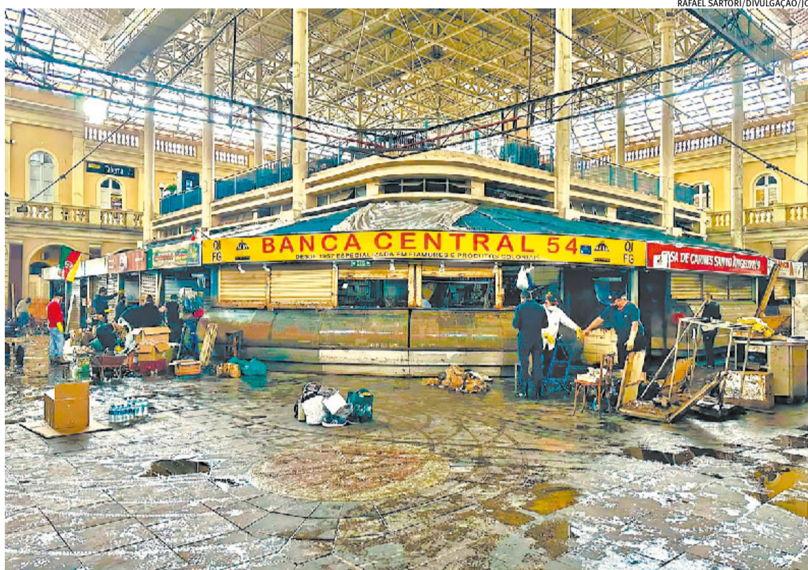
Alguns ocupantes do complexo de compras da Capital já puderam verificar a destruição causada no local
