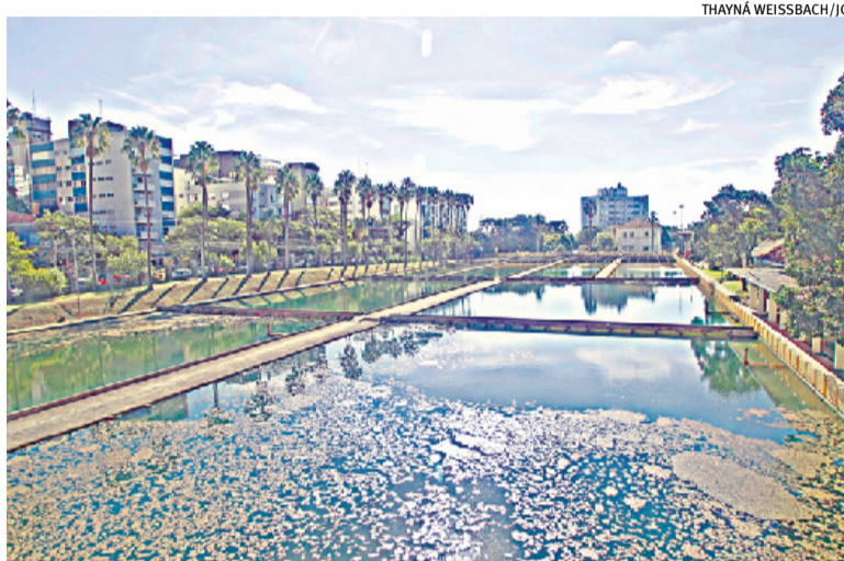
Estação que abastece 21 bairros depende de reparos na casa de bombas
