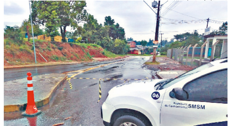
Acessos da cidade seguem bloqueados, sem previsão de reabertura
