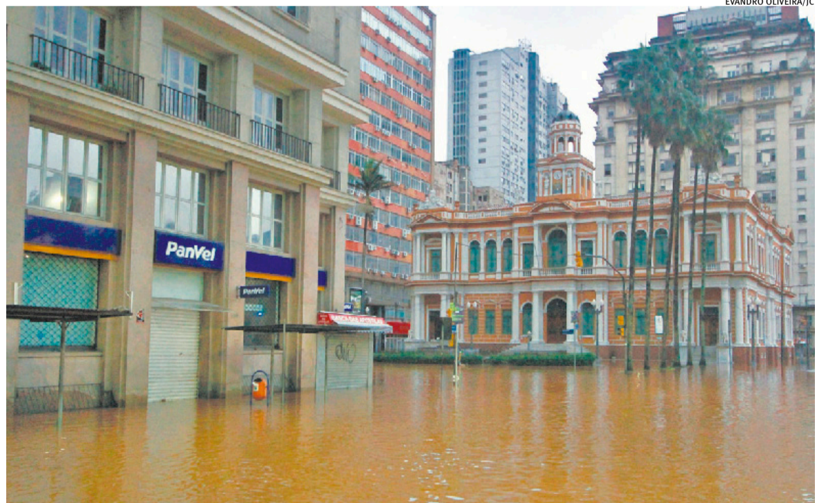
Obras abrigadas no Paço Municipal, antiga prefeitura, foram removidas para pavimentos superiores
