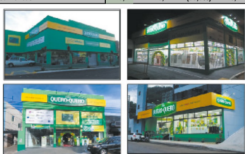
Em sentido horário: (i) Fachada filial de Agudos-SP; (ii) Fachada filial de Abatiá-PR; (iii) Fachada filial de Centenário do Sul-PR; e (iv) Foto da fachada da filial de Capinzal-SC;
