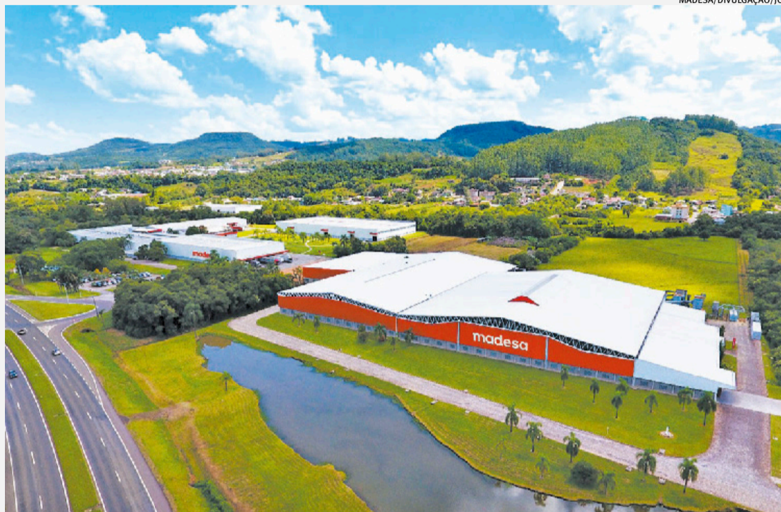
A fabricante de móveis Madesa está erguendo um centro de distribuição às margens da RS-122
