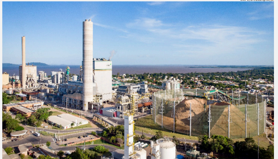
Com investimento, fábrica da CMPC em Guaíba ampliou capacidade em mais 350 mil toneladas de celulose por ano
