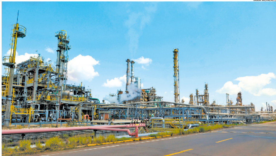
Investimento de R$ 550 milhões concluído na Refap em 2023 reduzirá as emissões atmosféricas
