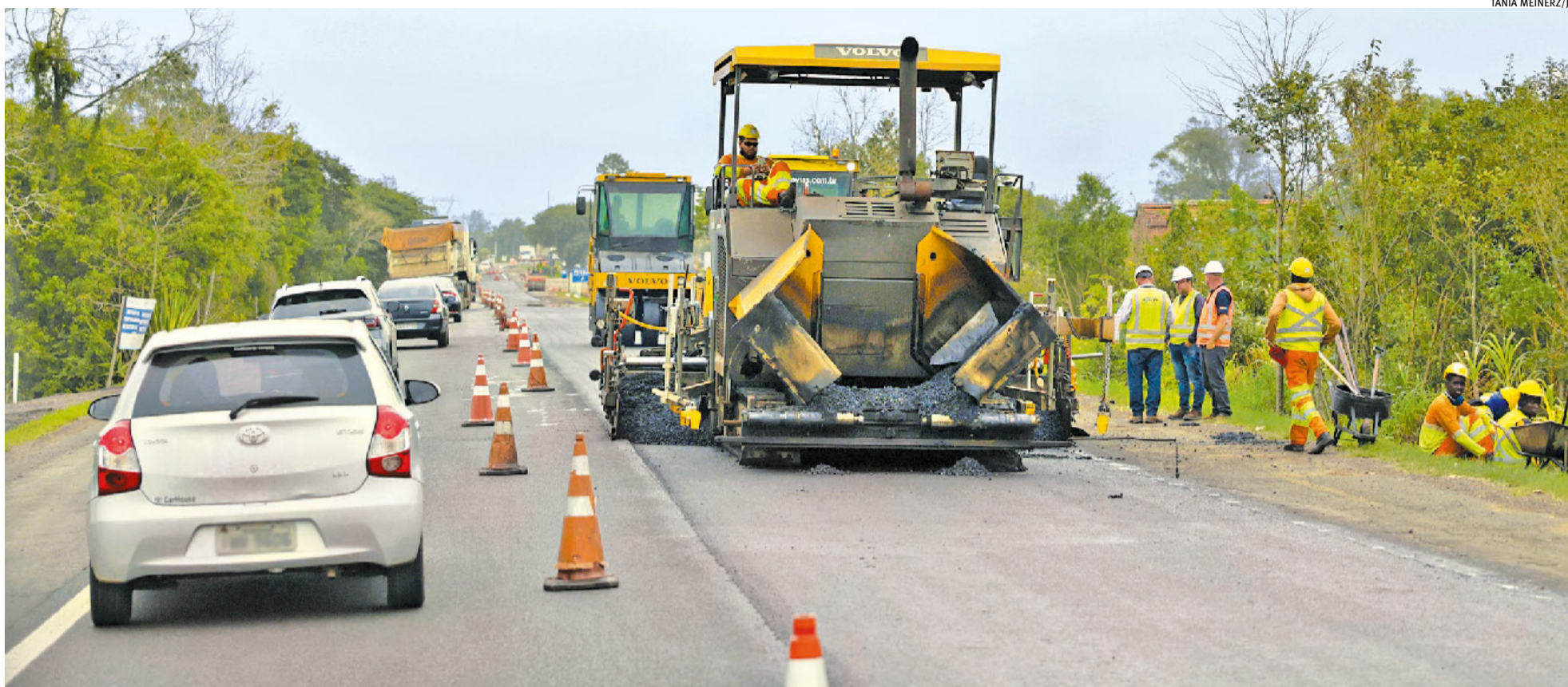
Obras na rodovia RSC-287, concedida para o grupo espanhol Sacyr; projeção é que 130 quilômetros da estrada sejam duplicados até 2026, com investimentos de R$ 1,5 bilhão
