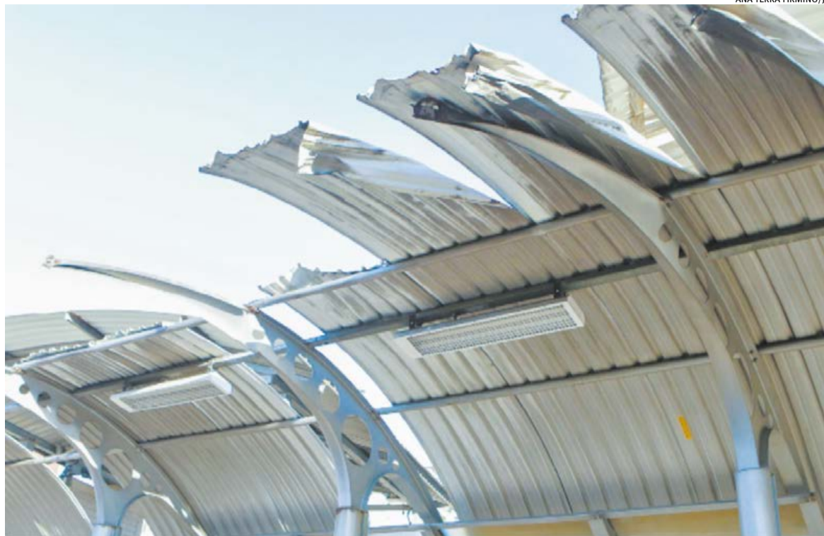
Terminal Mendes Ribeiro, na Zona Leste da Capital, tem parte da cobertura comprometida
