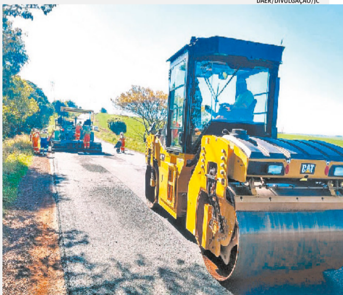
Obras de melhorias na rodovia ERS-330, no Norte do Estado
