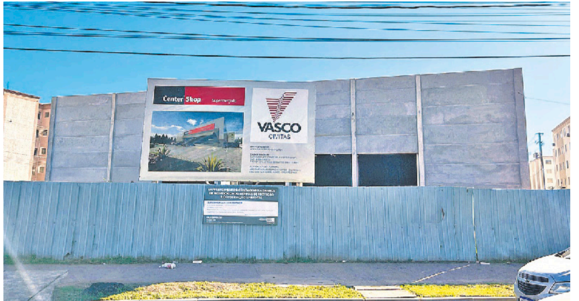
Obras de instalação do futuro empreendimento estão na etapa final no bairro Hípica, em Porto Alegre
